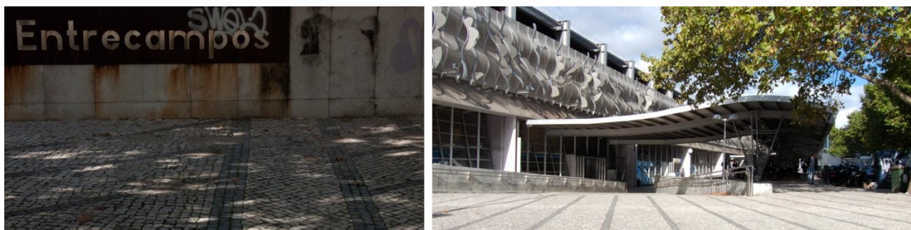
Fig. 08.5. Fotografia do Interface de Entrecampos
